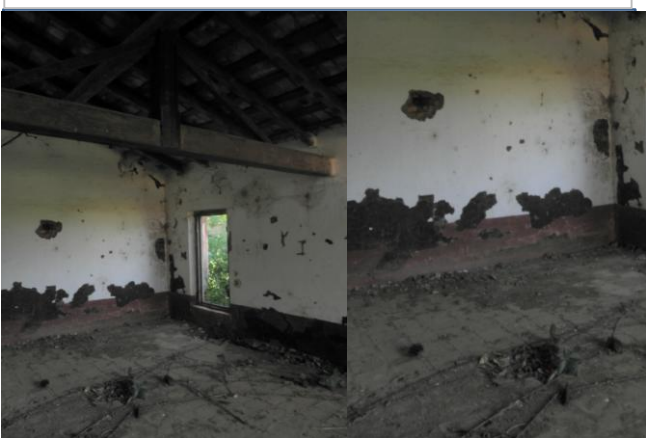
DESPRENDIMIENTO DE LA PINTURA, MANCHAS DE HUMEDAD, PUDRICION DEL MADERAMEN
