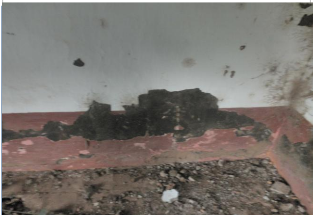
DESPRENDIMIENTO DE LA PINTURA, MANCHAS DE HUMEDAD
