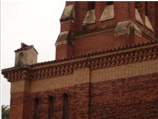
Detalle del trabajo en ladrillo en los remates de las cornisas de la Iglesia de los Migrantes.
