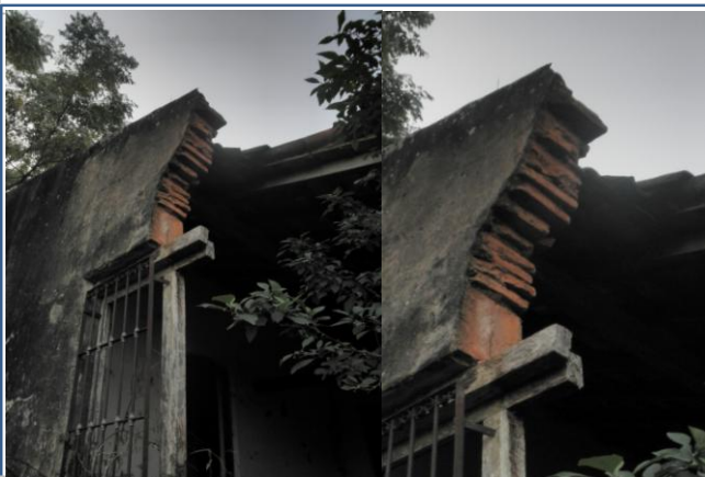
ESTRUCTURA DE ABERTURA EXPUESTA A LA INTEMPERIE, DESMORONAMIENTO DE LA ESTRUCTURA, MANCHAS DE HUMEDAD
