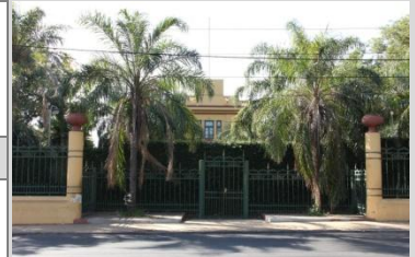
Vista actual de la Fachada Principal. No es posible ver el jardín debido al murallón construido por detrás de las rejas en un momento posterior.
