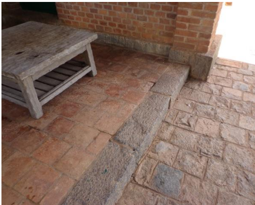
Piso exterior de ladrillos cerámicos y piedra.
