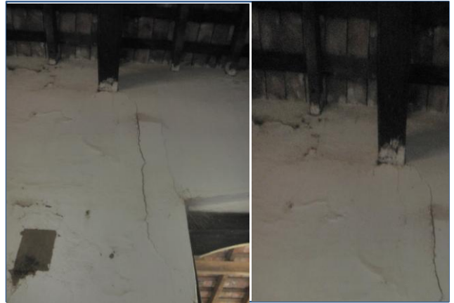
FISURAS Y GRIETAS EN PAREDES, DESCASCARAMIENTO DE PINTURA
