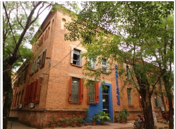
Imagen actual de la parte construida en 1930 – 1931. Actual acceso a la sede de Radio Caritas.
