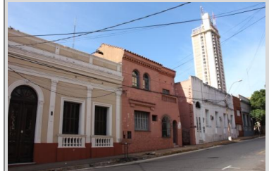
La vivienda mantiene la escala y tipología de fachada preponderante sobre Mcal. Estigarribia.
