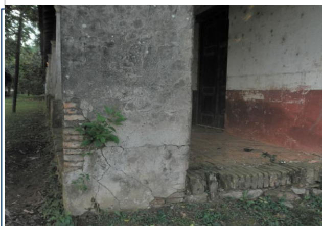
DESPRENDIMIENTO DE LA PINTURA, MANCHAS DE HUMEDAD, DESGASTE DEL PISO, DESPRENDIMIENTO DEL REVOQUE
