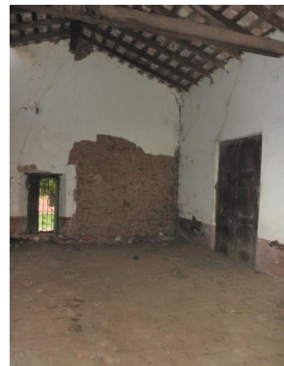
Fig.8: Desprendimientos de revoque
