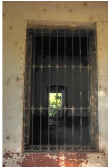
Fig.3: Desprendimiento de pintura
