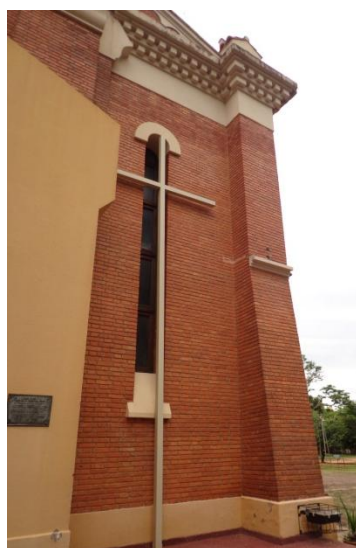
Iglesia de los Migrantes. Se observa el muro tipo contrafuerte en la esquina.
