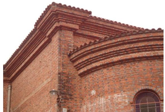
Mismo trabajo en ladrillo en los remates de las cornisas, en forma lineal y en el ábside de la Iglesia de los Migrantes.
