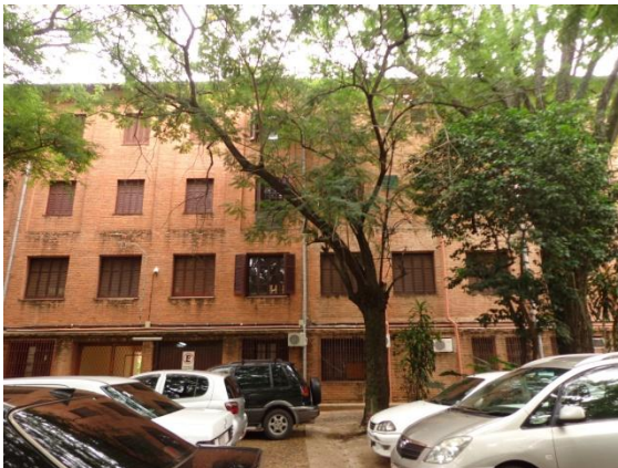
Fachada posterior. Aberturas con persianas de madera.
