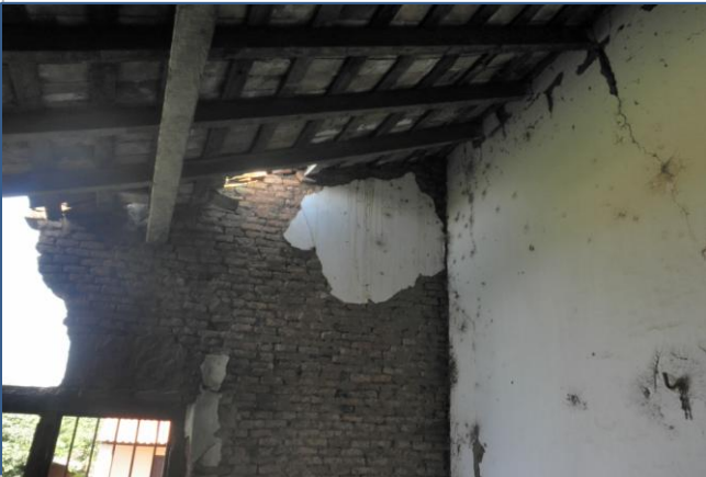
COLAPSO DE LA ESTRUCTURA, DESPRENDIMIENTO DEL REVOQUE, DESCASCARAMIENTO DE PINTURA, PUDRICION DEL MADERAMEN
