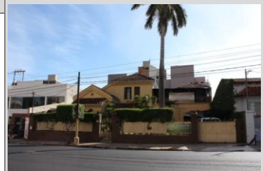
Vista actual de la Fachada Principal
