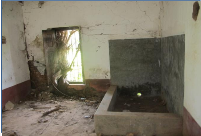
DESPRENDIMIENTO DEL REVOQUE, LEVANTAMIENTO DEL PISO, GRIETAS, ALIMAÑAS
