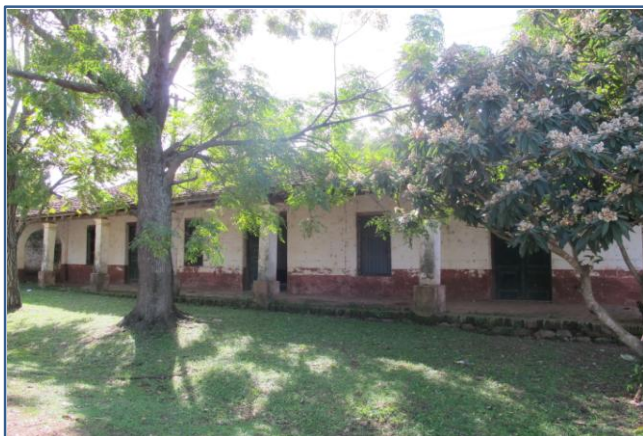
DESPRENDIMIENTO DE PINTURA (FACHADA PRINCIPAL)
