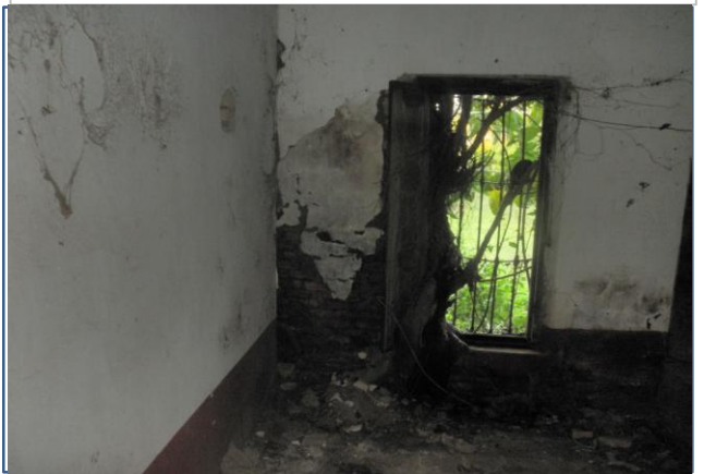
ASENTAMIENTO DIFERENCIAL, DESPRENDIMIENTO DEL REVOQUE, DESCASCARAMIENTO DE LA PINTURA, FLORA
