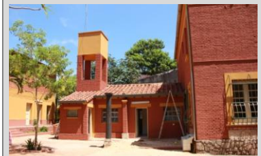
El área de servicio se ubica en la parte posterior. Se observa el tanque para suministro de agua, bajo el mismo existía una caldera que proveía de agua caliente a la vivienda. En el exterior aún queda en pie un pilar de madera (carcomida en su interior por el ú'i) de lo que fue un área para pérgola.
