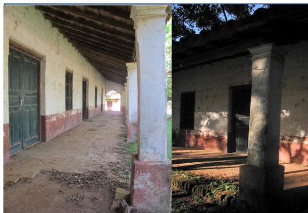
DESPRENDIMIENTO DE PINTURA, ROTURA Y LEVANTAMIENTO DE PISOS (GALERIA)
