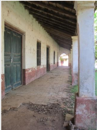
Fig.2: Asentamiento en pisos
