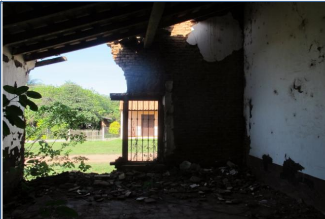
COLAPSO DE LA ESTRUCTURA, DESPRENDIMIENTO DEL REVOQUE, ENTRADA DE FLORA AL INTERIOR
