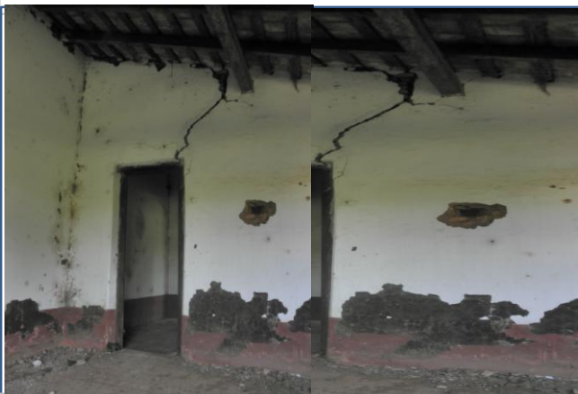
ROTURA DE TEJAS, DESPRENDIMIENTO DEL REVOQUE, GRIETAS A 45°, MANCHAS EN LAS PAREDES.
