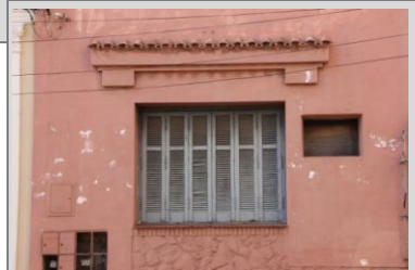
Abertura en planta baja rectangular con postigos de madera. Detalle: el alero a modo de dintel sobre ménsulas y tejas españolas cortadas.
