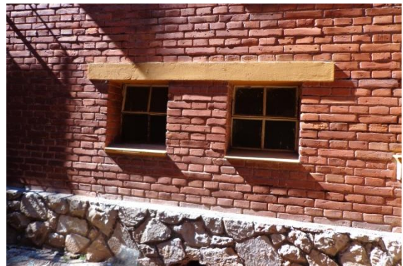
El uso de diversos materiales y texturas en la fachada, como la piedra, el ladrillo, el dintel de H° revocado, etc.
