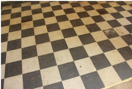
Detalle del piso en la galería de acceso. Granito en color blanco y negro. Diseño tipo damero.
