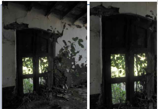
MANCHAS DE HUMEDAD (MOHO), DESPRENDIMIENTO DEL REVOQUE, FLORA EN EL INTERIOR
