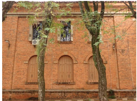
Vista de las aberturas con arcos de medio punto, ventanas vidrieras y persianas de madera.
