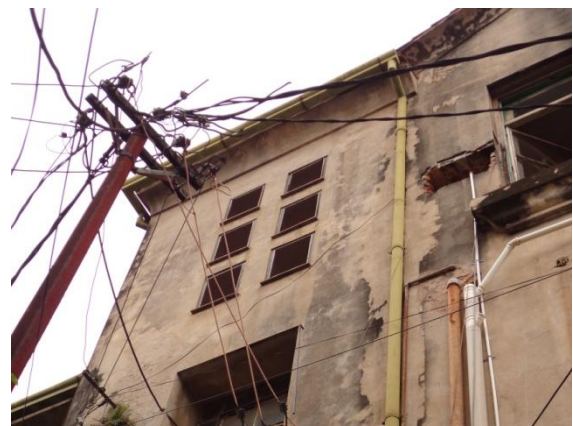
Vista de las aberturas en la caja de escalera.
