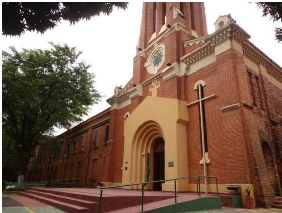
Fachada principal. Iglesia de los Migrantes. Uso del ladrillo visto. Muro contrafuerte en esquina y molduras en bandas de diseño geométrico en los remates.
