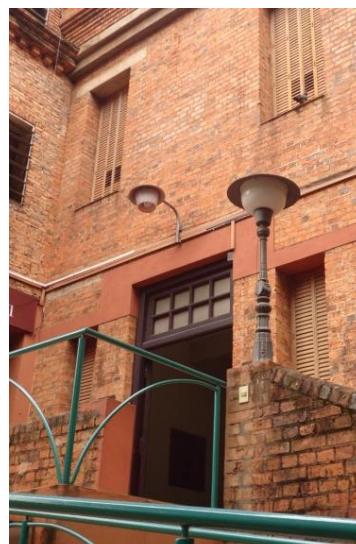
Detalle de la luminaria en el acceso al Salón de actos.
