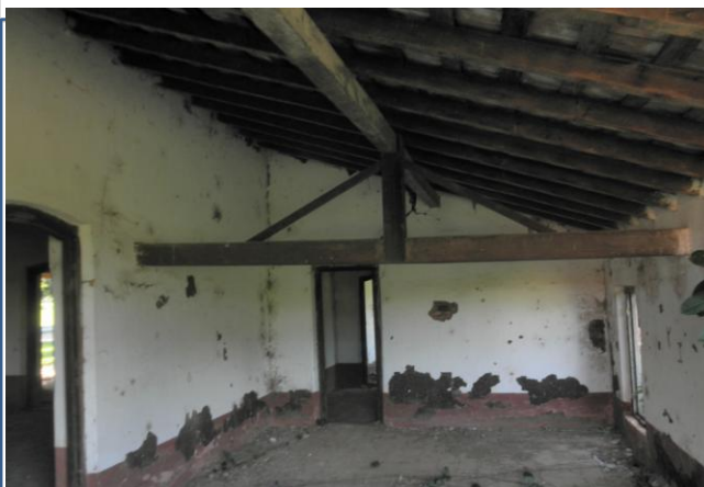
GRIETAS Y FISURAS EN PAREDES, MANCHAS DE HUMEDAD, PUDRICION DE MADERAMEN
