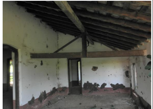
Fig.6: Manchas de humedad en paredes
