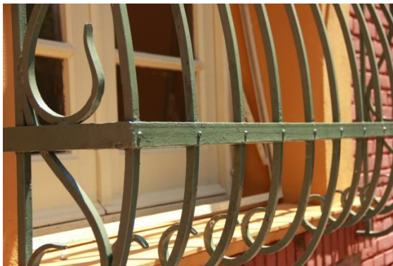
Detalle de la reja en las aberturas en la planta baja. De hierro trabajado artísticamente, su diseño es simple con motivos geométricos.
