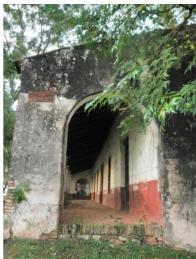
Fig.7: Vista de la galería
