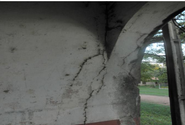
GRIETAS Y FISURAS EN EL ARCO DE LA FACHADA, MANCHAS DE HUMEDAD, DESPRENDIMIENTO DE PINTURA
