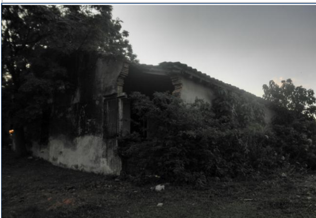
DESMORONAMIENTO DE PAREDES EN LA FACHADA LATERAL, MANCHAS DE HUMEDAD, CRECIMIENTO DE FLORA
