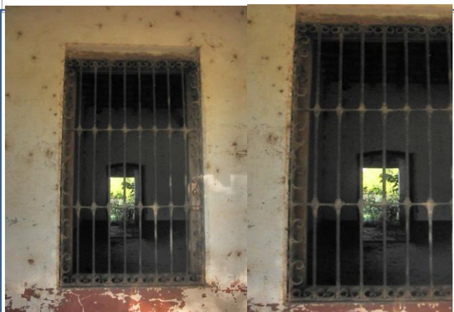
POLVO Y ALIMAÑAS EN LAS ABERTURAS, DESPRENDIMIENTO DEL REVOQUE Y DE PINTURA
