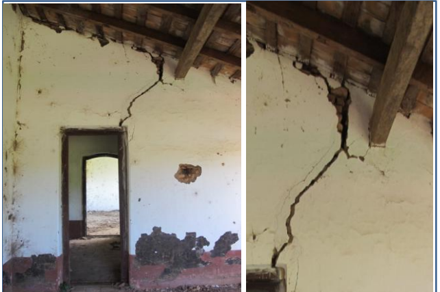
GRIETAS A 45°, ASENTAMIENTO DIFERENCIAL, DESPRENDIMIENTO DEL REVOQUE, DESCASCARAMIENTO DE LA PINTURA
