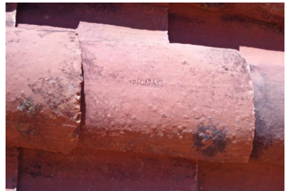
Detalle de las tejas cerámicas tipo españolas del techo. En cada una de ellas se lee "YPACARAI" como una marca de fábrica.
