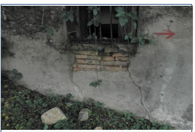
MANCHAS DE HUMEDAD (MOHO), FISURAS, DESPRENDIMIENTO DEL REVOQUE, FLORA EN EL INTERIOR
