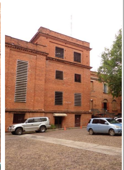
Vista posterior. Sencillez y solidez en el volumen de la obra.
