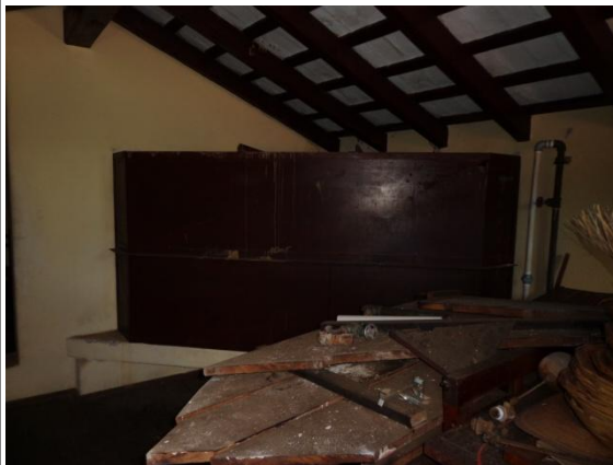
Entrepiso. Vista del antiguo tanque de suministro de agua para la vivienda.
