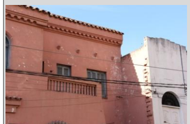
Molduras con forma semicircular a lo largo del alero. Balcón sobre la calle principal.
