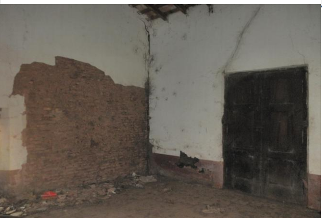
GRIETAS Y FISURAS EN PAREDES, MANCHAS DE HUMEDAD, DESPRENDIMIENTO DEL REVOQUE, PUDRICION DE MADERAMEN
