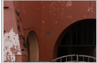
Pequeña placa en la entrada de la vivienda con la siguiente inscripción: "Arq. Tomás R. Pereira Ctor. Pedro P. Pedroso"
