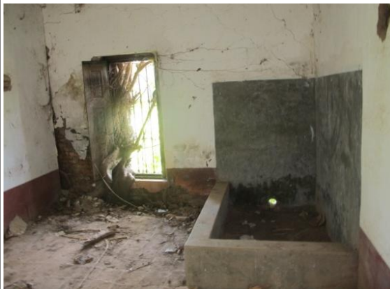
Fig.5: Fisuras en paredes. Plantas en el interior
