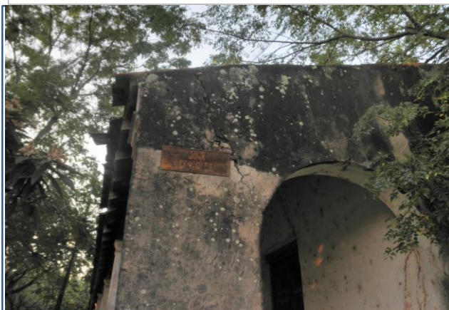
MANCHAS DE HUMEDAD (MOHO), DESPRENDIMIENTO DEL REVOQUE Y LA PINTURA
